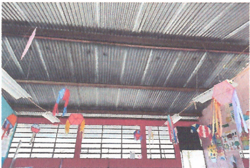
Foto 3: Reparación y mantenimiento del Sistema eléctrico en aulas
