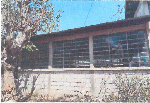
Foto 1: Instalación de balcones tipo barrotes para ventana
