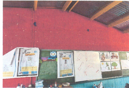
Foto 2: Pintura en interior de aulas
