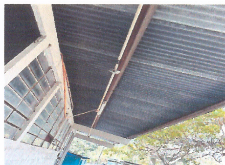
Foto 4: Reparación y mantenimiento del Sistema eléctrico en corredores
